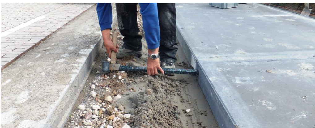
figuur 6 montage kunststof wig tussen de Easypath® elementen
